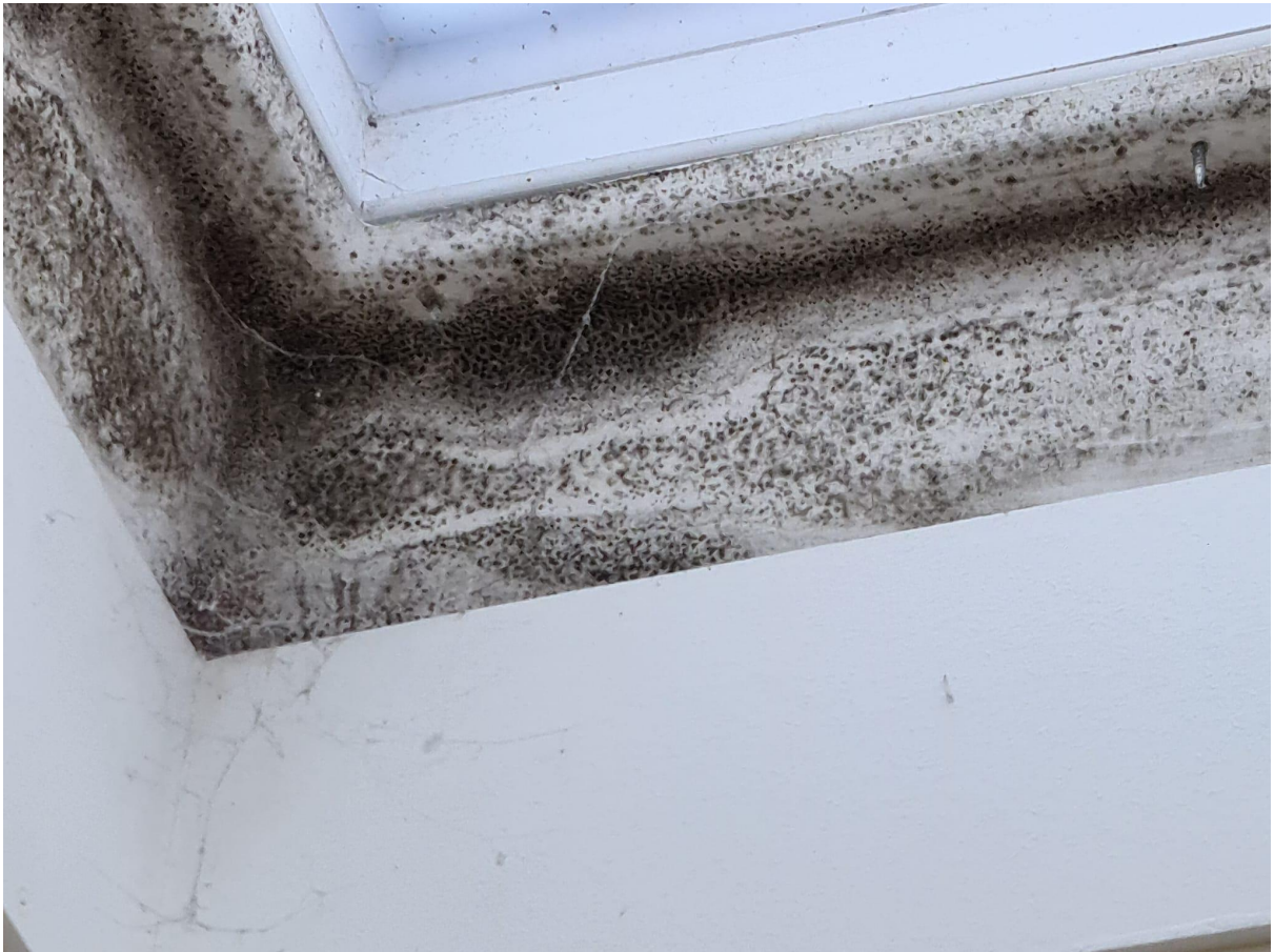
Als Anlage: Dachfenster der Anne-Frank Sporthalle.
